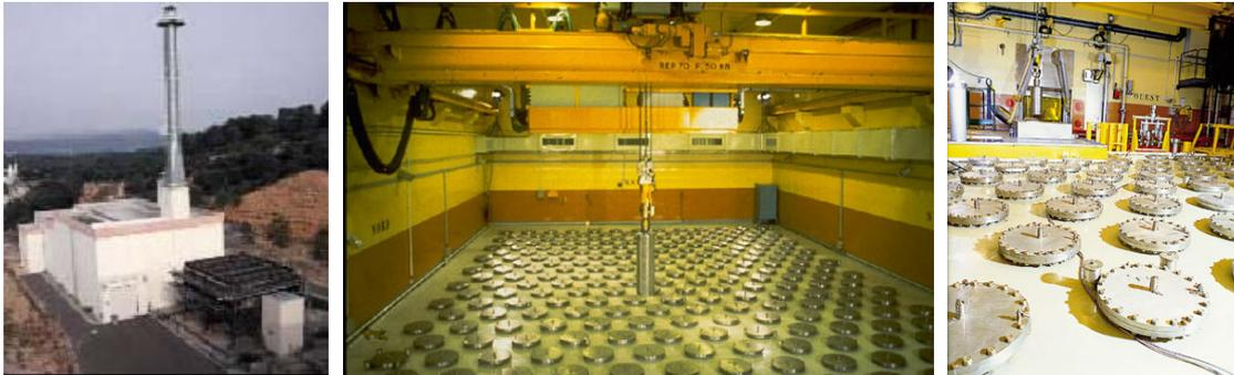
*Casemate d'entreposage à sec de Cadarache (CASCAD) : au milieu, cellule de maintenance des colis, à droite, vue rapprochée des têtes de puits d'entreposage [source CEA]*
