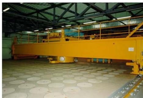
Installation d'entreposage E-EV-SE à La Hague (à gauche, vue en coupe montrant le refroidissement des colis entreposés par convection d'air ; à droite en bas, hall de manutention des colis situé au-dessus des puits d'entreposage dans lesquels les colis sont empilés)
