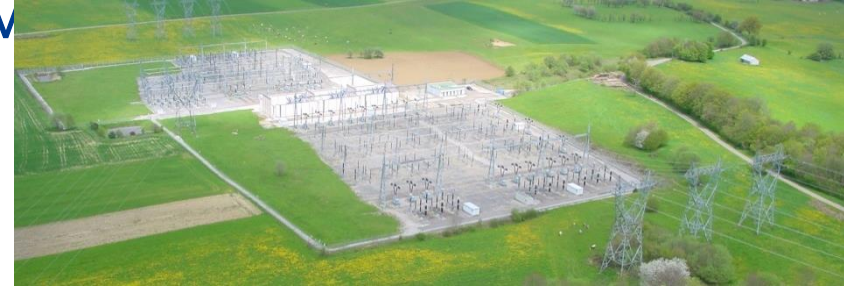
Exemple de poste 400 000 / 225 000 volts à Mambelin dans le Doubs
