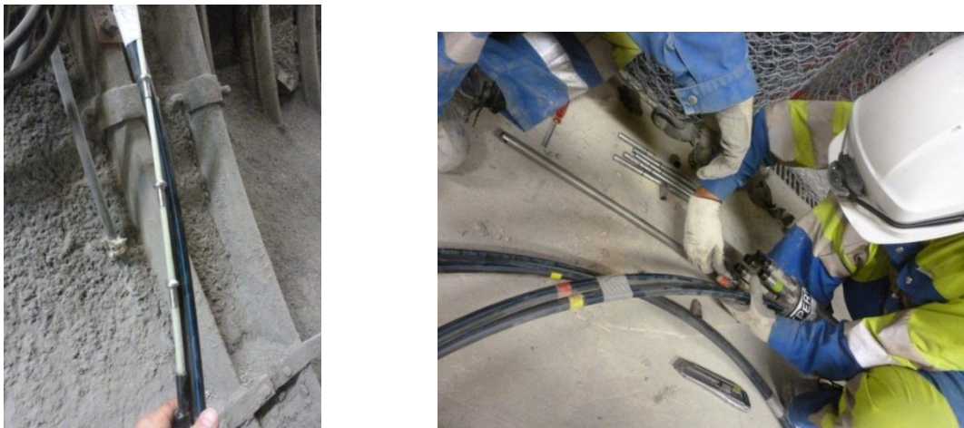
Figure 23 Mise en place de l'extensomètre multi-points dans le forage GGD4003
