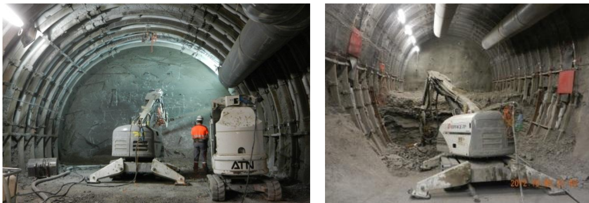
Figure 4 Creusement de la galerie GRD3 : à gauche demie supérieure et à droite demie inférieure
