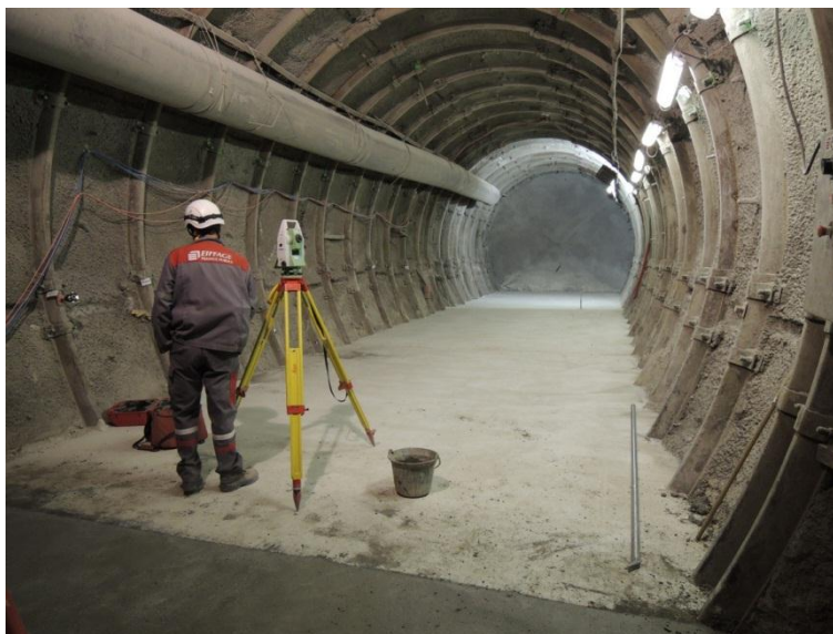
Figure 7 Galerie technique G10 (nouvelle sous-station électrique et niche informatique)
