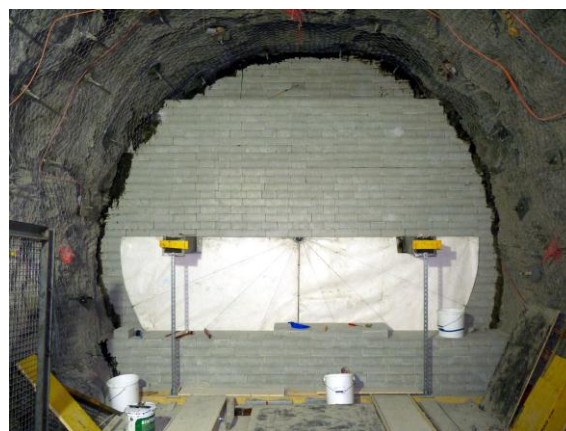
Pose de la seconde membrane d'hydratation
