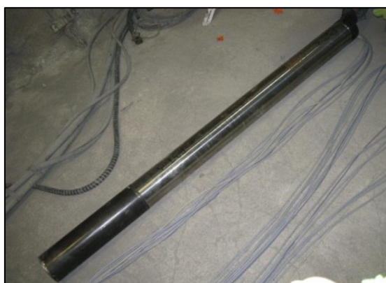
Figure 26 Tubage instrumenté installé dans CAC1003
