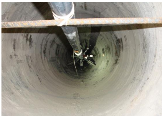
Figure 12 Dispositif de convergence en place dans l'alvéole ALC3002
