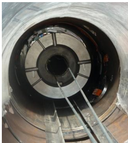
Figure 29 Alvéole ALC1604, vue d'un élément chauffant dans le chemisage
