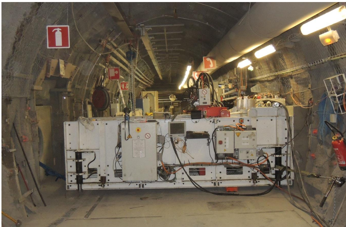
Figure 8 Machine utilisée pour le creusement des alvéoles HA
