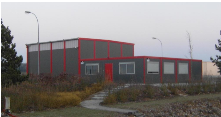
Figure 35 Centre de secours du Laboratoire
