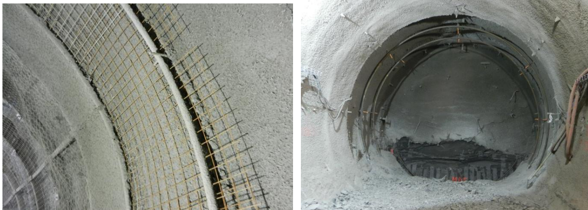
Figure 3 Différentes épaisseurs de béton projeté dans la galerie GRD2
