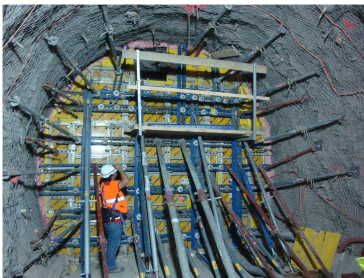
Figure 13 Coffrage du mur béton en fond de la galerie GCS
