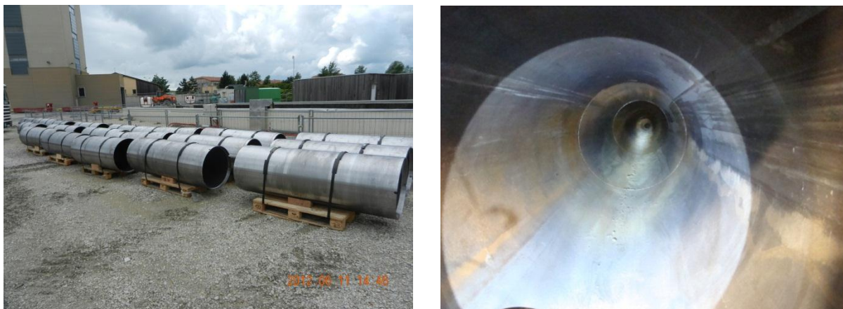
Figure 10 Chemises métalliques (à gauche) insérées au fur et à mesure du creusement dans l'alvéole (à droite)
