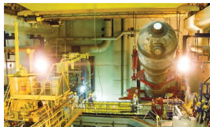
Démantèlement de la centrale de Chooz.
