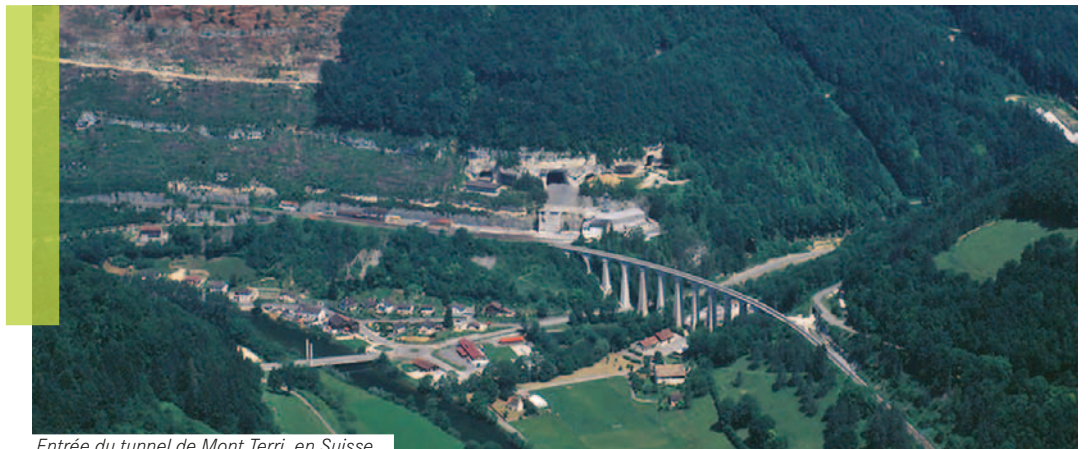
Entrée du tunnel de Mont Terri, en Suisse.
