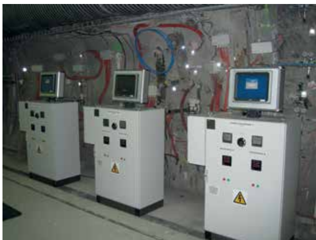
Figure 8 : Les dispositifs de régulation de chauffe de l'expérimentation TED
