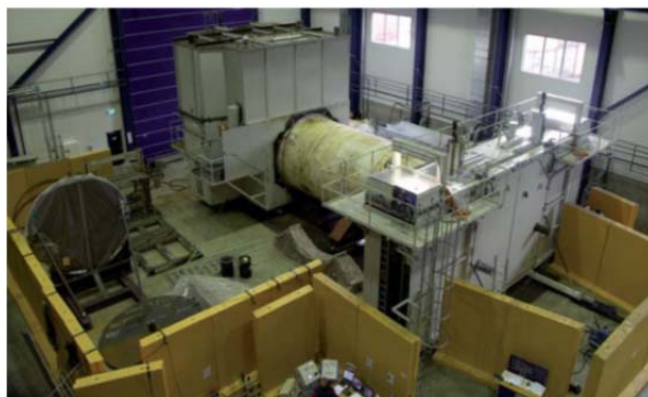
Figure 4 : Studsvik-Nykoping : atelier de démontage des générateurs de vapeur
