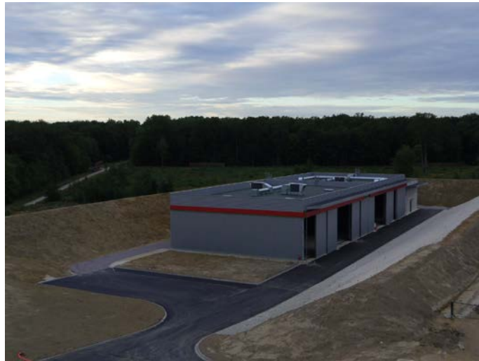
Vue du bâtiment d'entreposage
