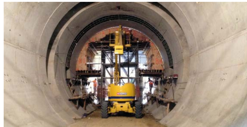
Préparation d'un essai industriel de scellement d'un galerie
