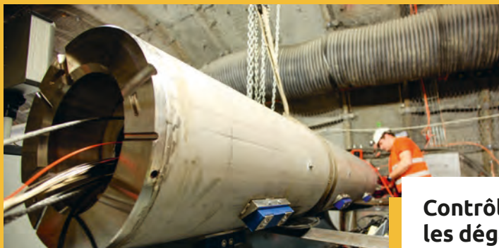
Grâce à cette sonde chauffante, le démonstrateur d'alvéole HA est monté en température par paliers jusqu'à 100 °C et plus, ce qui permet d'étudier l'élévation de température sur le tubage en acier ainsi que sur la roche environnante.
