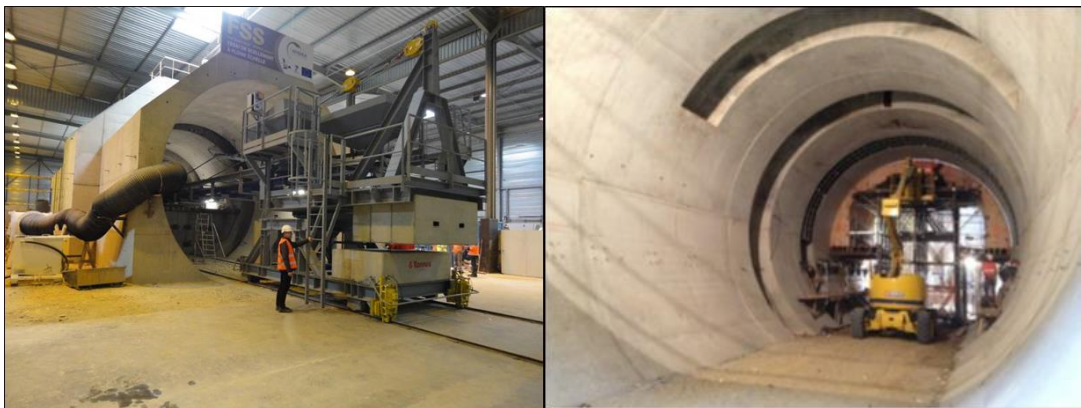
Figure 3.4-4 : Essai de réalisation de scellement
