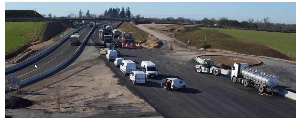
Réalisation de voiries
