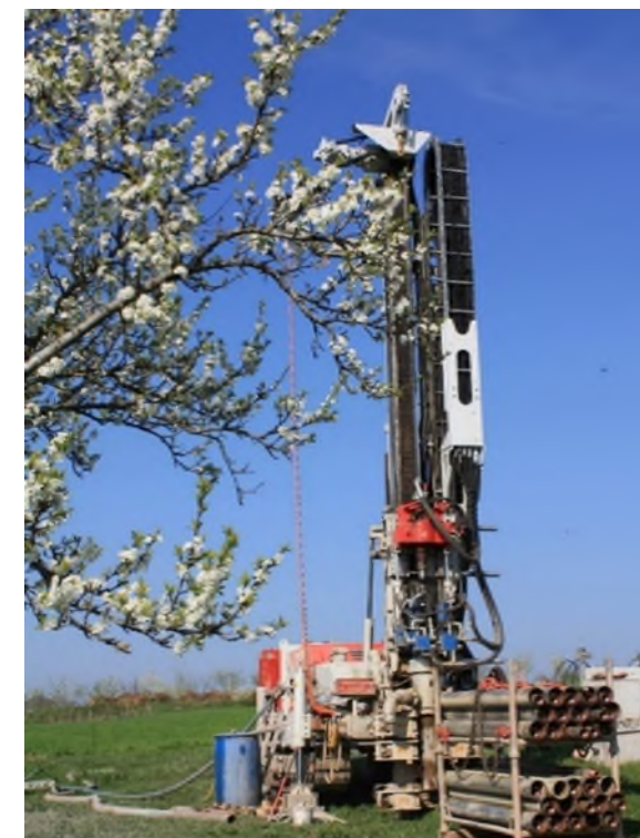
Géotechniques et campagne de forages
