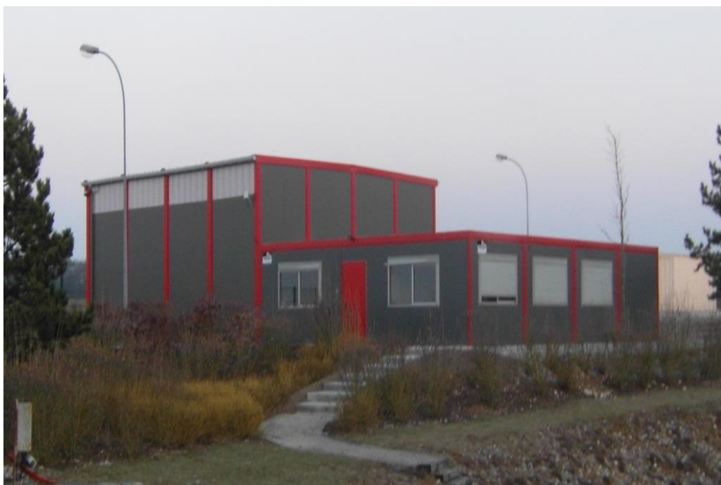
Figure 1-5 Centre de secours du Laboratoire souterrain
