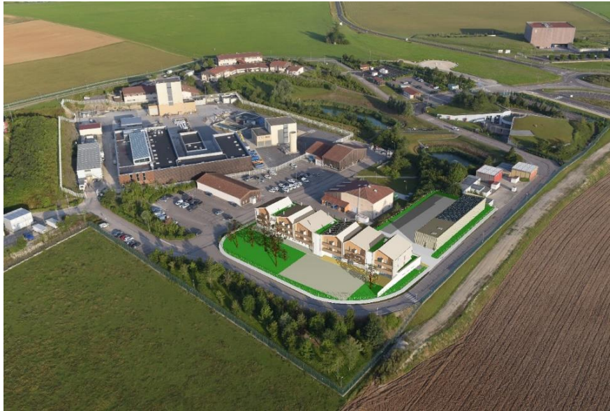
Figure 2-1 Insertion du projet dans son environnement
