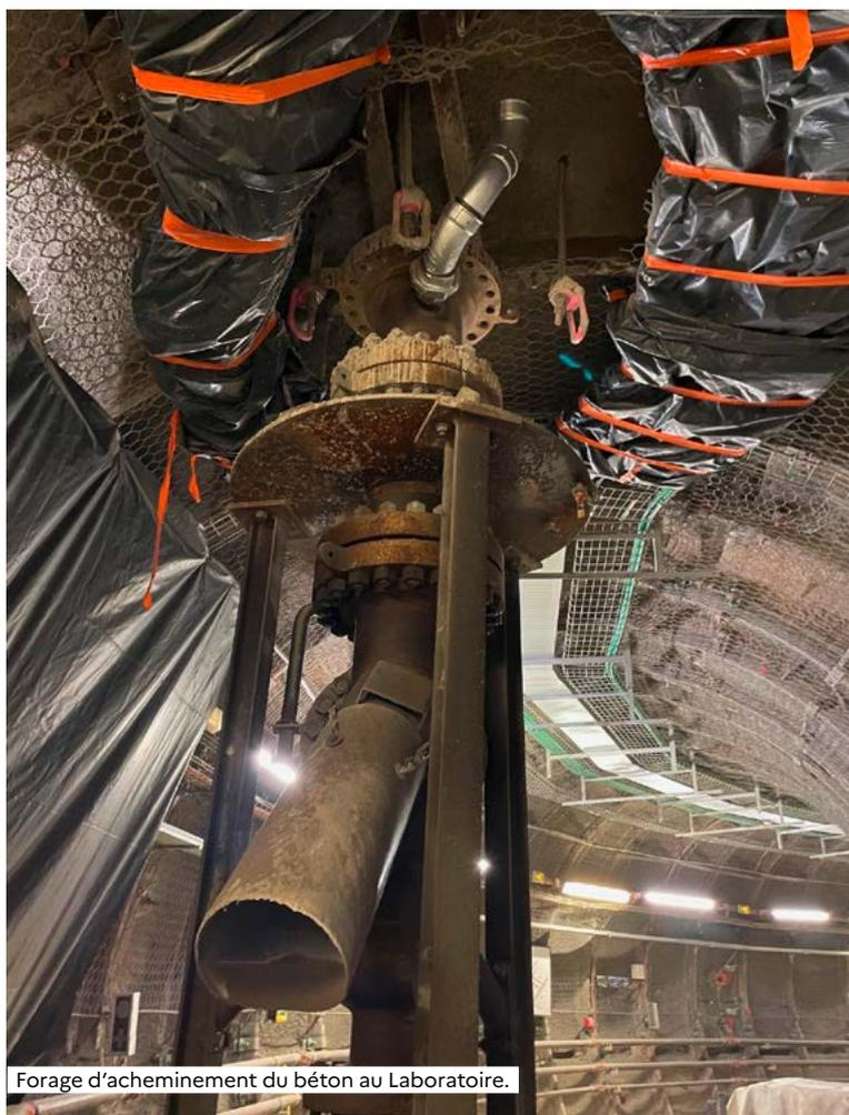
Forage d'acheminement du béton au Laboratoire.
