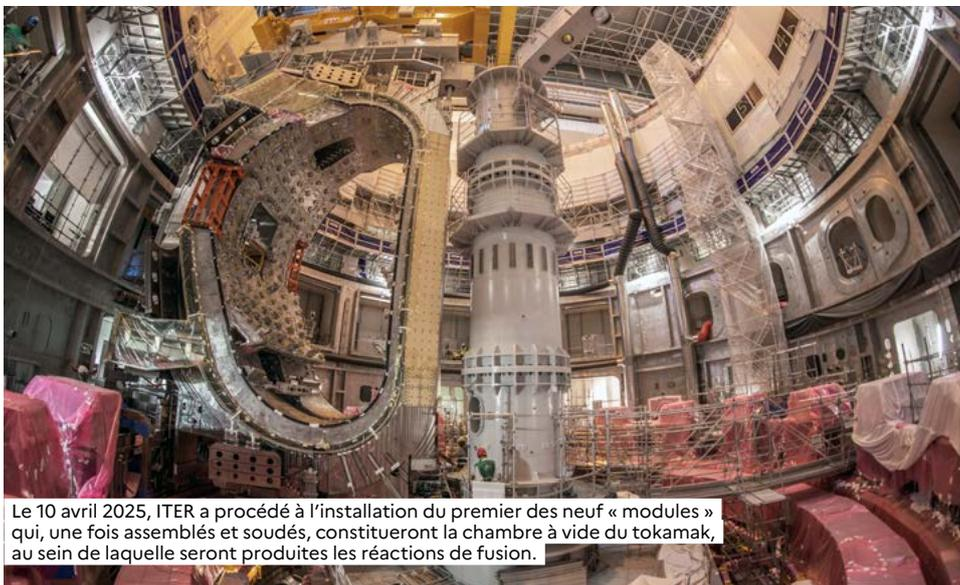
Le 10 avril 2025, ITER a procédé à l'installation du premier des neuf « modules » qui, une fois assemblés et soudés, constitueront la chambre à vide du tokamak, au sein de laquelle seront produites les réactions de fusion.
