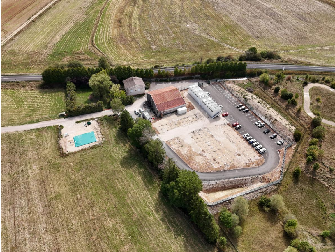
> Base vie ferme du Cité
