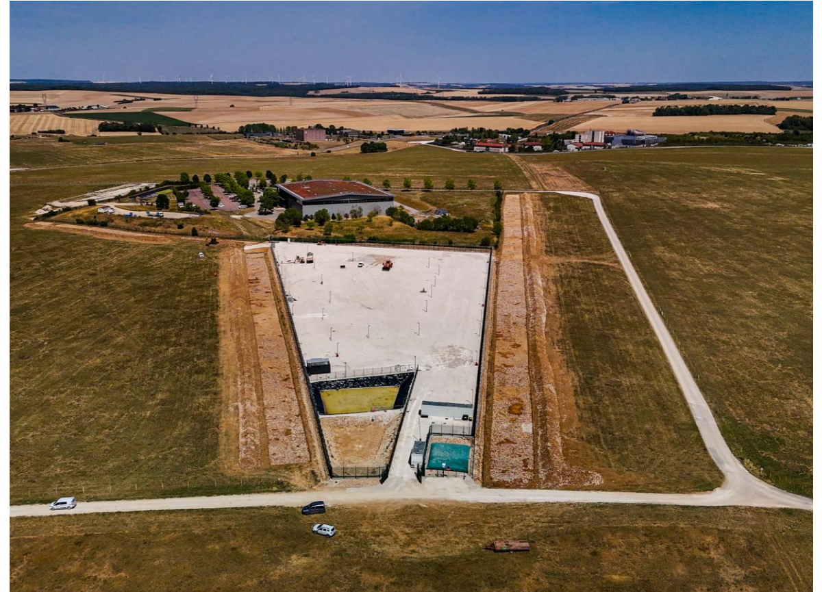
> Base vie Ete3
